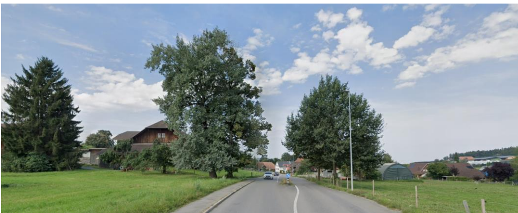
Optische Torwirkung durch Bäume in Kombination mit minimalem Horizontalversatz (Tägertschi; Bildquelle: Google Maps)
