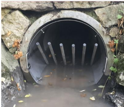
Abbildung 5 Biberschutzrohr (Quelle Urbanum AG)
