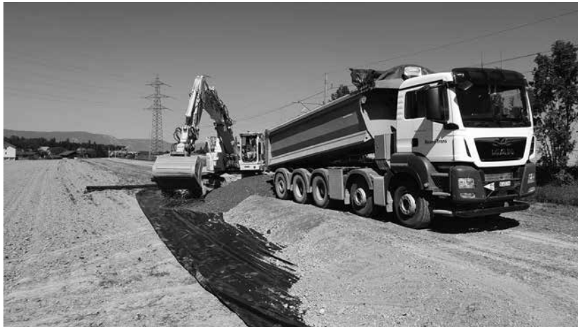
Schütten Baupiste nach Hambüelwald Grafenried
