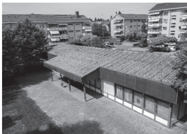
Alter Pavillon vor dem Abbruch
