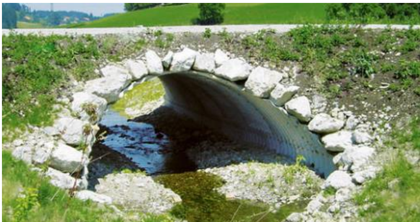
Abbildung 24: Beispiel Wellstahlkonstruktion Maulprofil, Bild: Sytec
