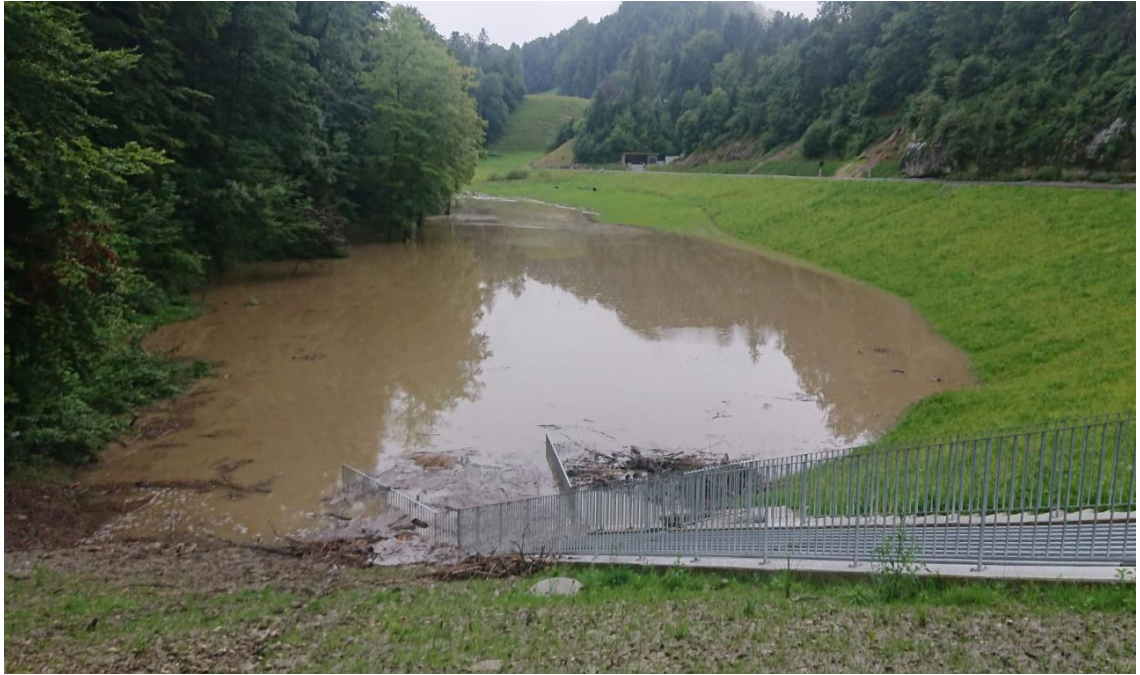
Abbildung 28: Einstau RHB Luterbach Oberburg Juli Hochwasser 2021, Foto: Feuerwehr Oberburg
