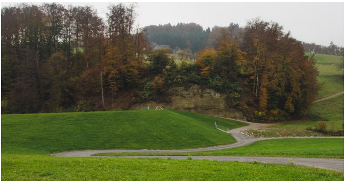
Abbildung 27: Luftseitige Ansicht Rückhaltedamm Chappelenbach Wynigen, Foto: K+Z AG
