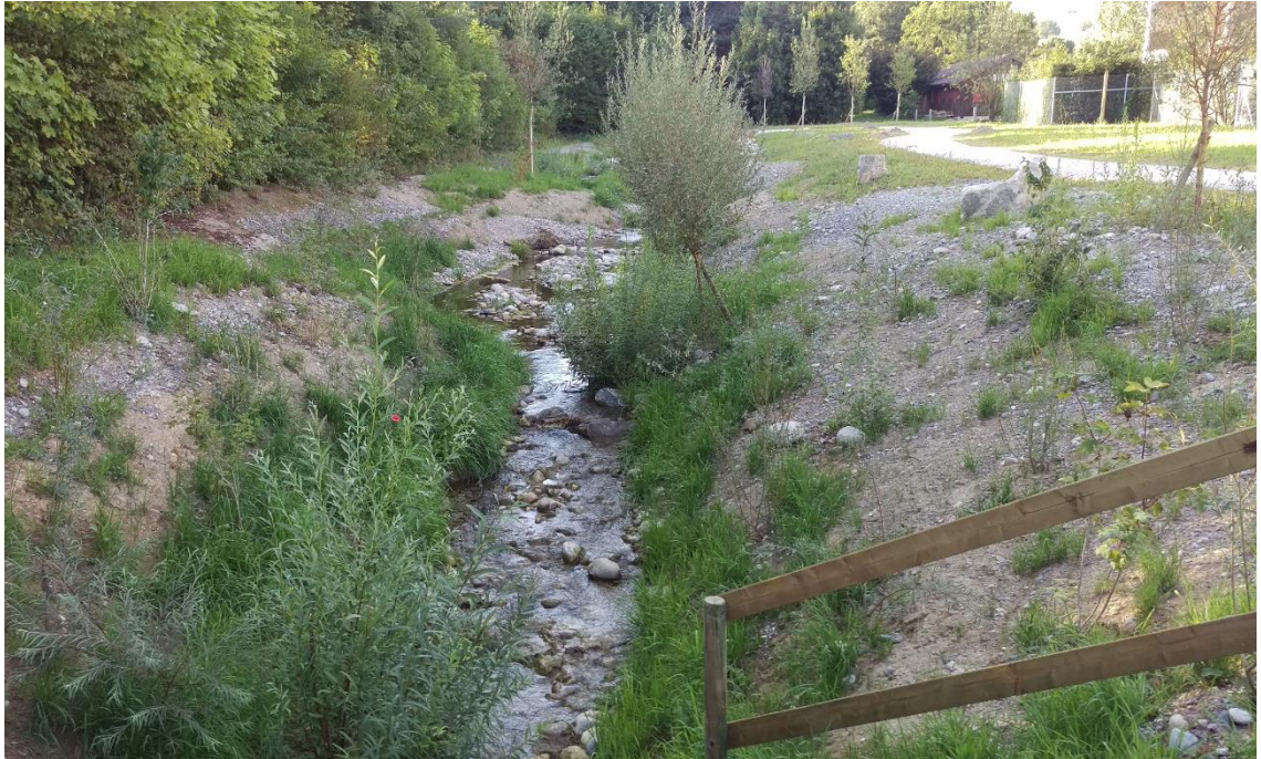
Abbildung 23: Beispielbild, renaturierter Lutertalbach Bolligen ca. 4 Mt. nach Bauabschluss, Foto: K+Z AG
