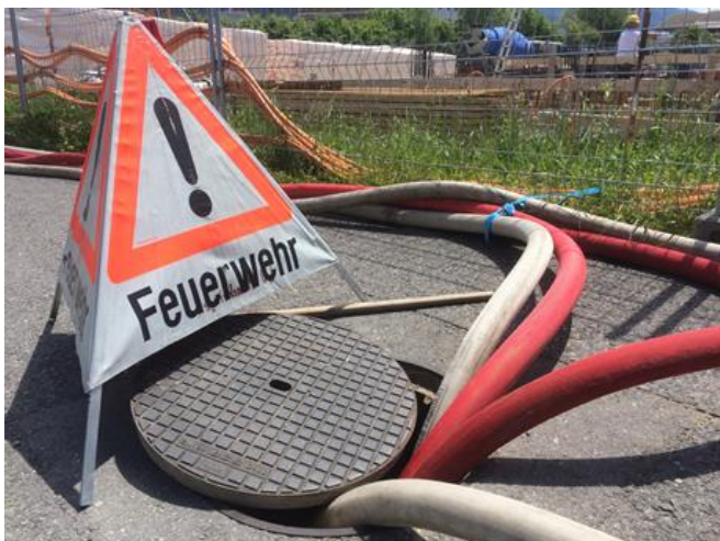
Die Kanalisation vermochte das eingepumpte Wasser abzuführen.
