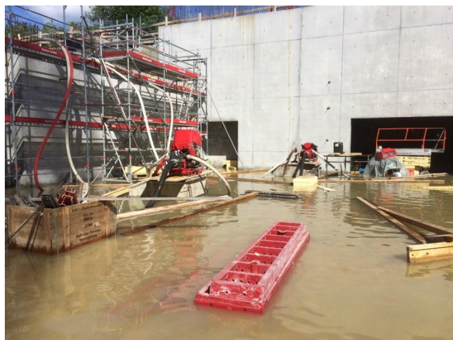
Die Grossbaustelle ID wurde gleich zweimal überflutet. Mittels Baukran wurden die Motorspritzen auf die Baustelle gehoben. Bei strahlendem Sonnenschein erfolgte das Abpumpen von mehreren tausend Qubikmetern Wasser.
