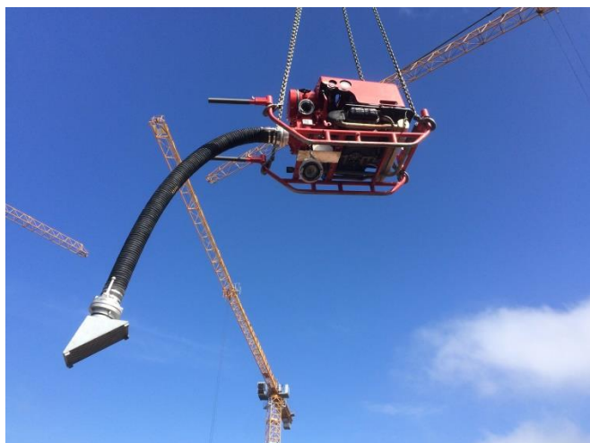
Die Grossbaustelle ID wurde gleich zweimal überflutet. Mittels Baukran wurden die Motorspritzen auf die Baustelle gehoben. Bei strahlendem Sonnenschein erfolgte das Abpumpen von mehreren tausend Qubikmetern Wasser.
