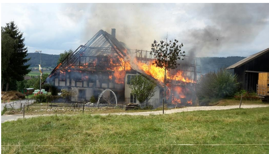
Grossbrand Bauernhaus Limpach; Nachbarhilfe bei der Feuerwehr Fraubrunnen.
